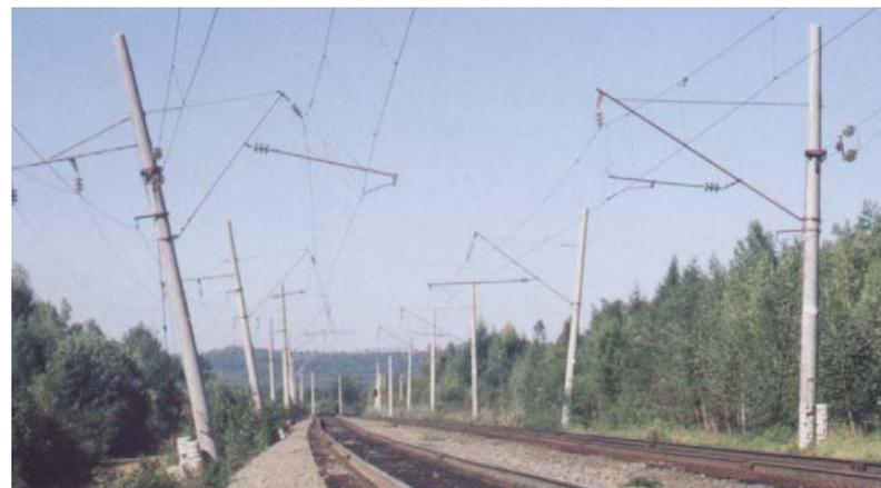
Деформации опор контактной сети Забайкальской железной дороги на участке Сегачама – Б. Омутная
