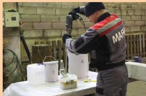
Свежеприготовленную композицию покрытия следует наносить на поверхность сваи кистью в продольном направлении, по всем граням тела сваи, для исключения поперечных поясков утолщений покрытия и снижения противопучинного эффекта. При этом необходимо обеспечить равномерное и сплошное нанесение композиции на поверхность, не допускать подтеков и пропусков.
