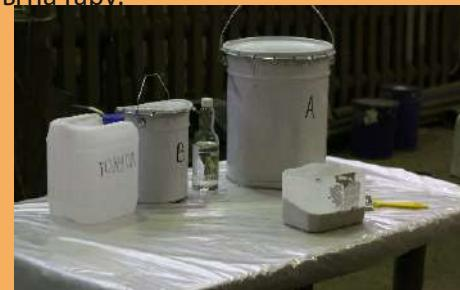
Количество приготавливаемого объема композиции должно быть оптимальным, исходя из времени жизнеспособности покрытия, объема обрабатываемой поверхности и условий нанесения.
