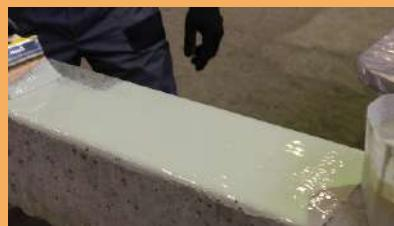
Слои противопучинного покрытия следует наносить однородной пленкой с толщиной 250-500мкм. Для получения покрытий толщиной до 2мм, необходимо обеспечить режим нанесения и промежуточной сушки каждого слоя до получения необходимой проектной толщины покрытия.
